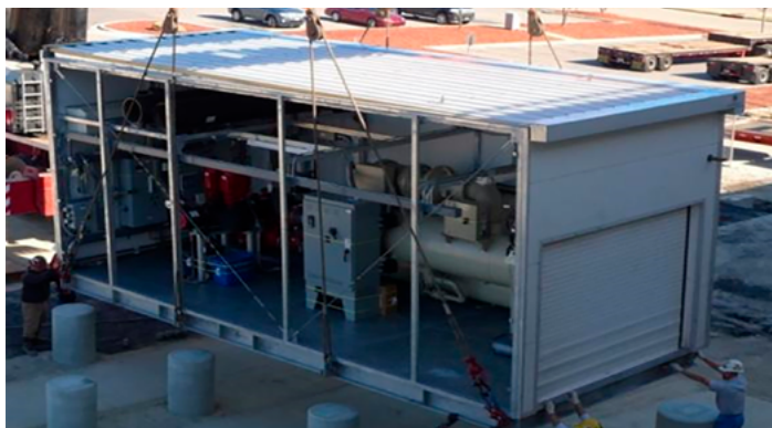
La planta modular de Daikin (MCP) incorpora enfriadoras, bombas, tuberías de agua helada, sistemas de control y torres de enfriamiento en un módulo pre ensamblado de fábrica.
