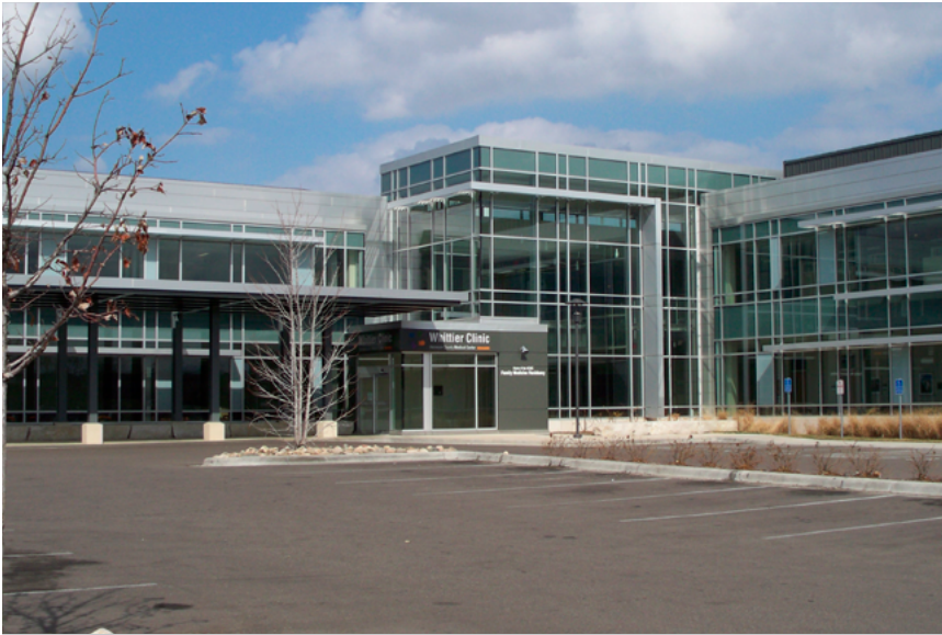
La clínica Whittier es la primera instalación de atención médica en Minneapolis en obtener la certificación LEED® para nueva construcción
