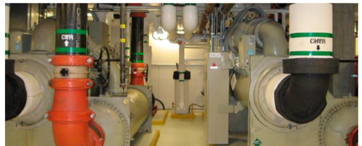
Los enfriadores centrífugos Daikin de 900 toneladas instalados en la configuración de contraflujo en serie en Abbotsford Hospital.
