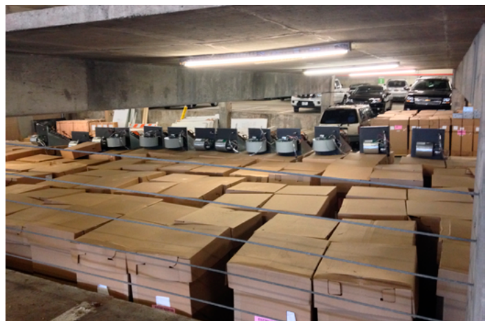
Línea de fan coils verticales apilados en el estacionamiento del hotel donde los equipos técnicos realizaron los trabajos de preparación de las nuevas unidades.
