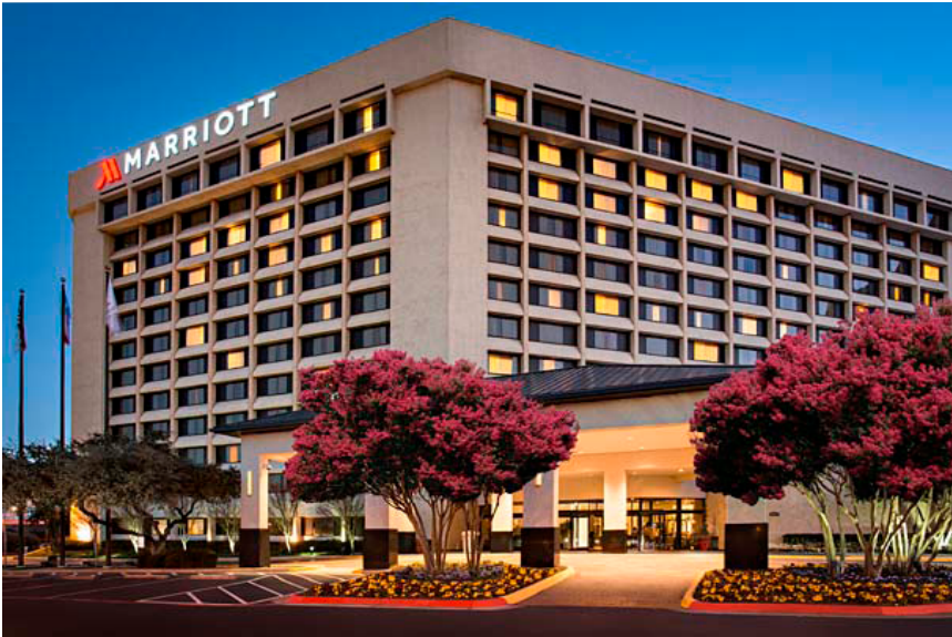
El hotel Marriott Quorum, ganador del ENERGY STAR, se encuentra entre los principales sitios de restaurantes, entretenimiento y compras del área norte de Dallas y recibe reseñas favorables de huéspedes y empresas
